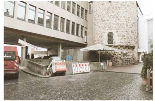
Foto aktuell, Situation neben dem Druselturm mit Einfahrt Tiefgarage und Lagerfläche
